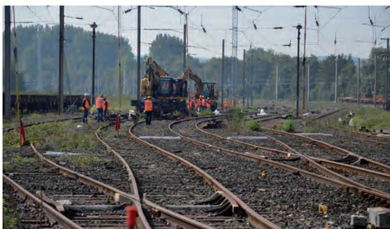
Travaux d'entretien ferroviaire
